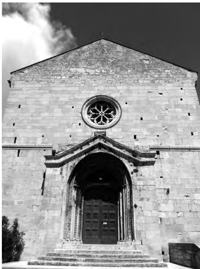
Fig. 4 - Facciata della chiesa di S. Francesco sulle pendici della collina del Castello (fotografia scattata il 6 giugno 2013).
