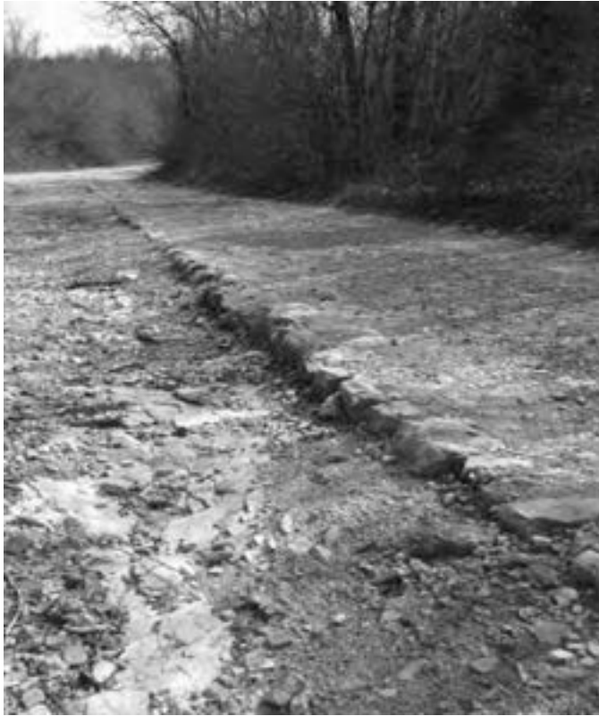
Resti del bordo a testimonianza che la strada era rialzata rispetto al livello del terreno
