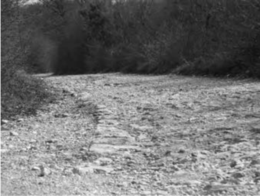
Tratto con bordo che testimonia un tracciato differente da quello della strada odierna
