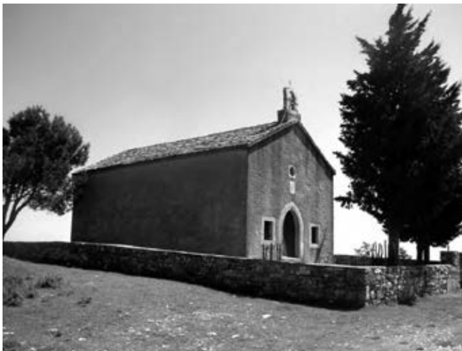
Castelnuovo d'Arsa, S. Agnese, ripresa da nord-ovest
