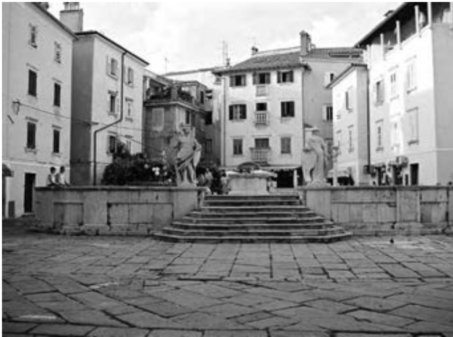
Ill. 3 - Pirano: la cisterna (1766; vista da sud), con la scalinata e le sculture della Legge e della Giustizia (Foto: Anja Burić)
