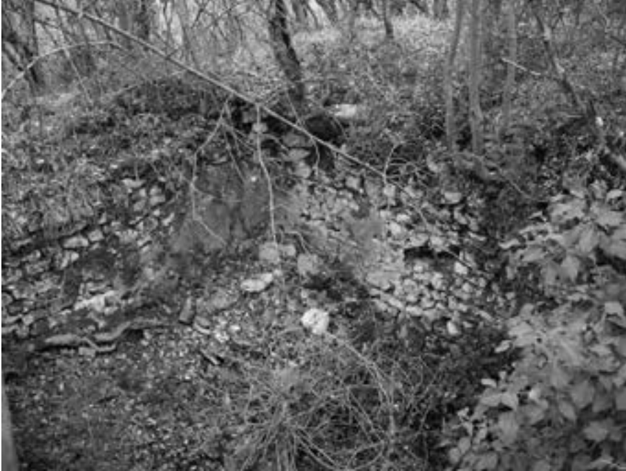
Foto 4 – Le murature della cisterna.
