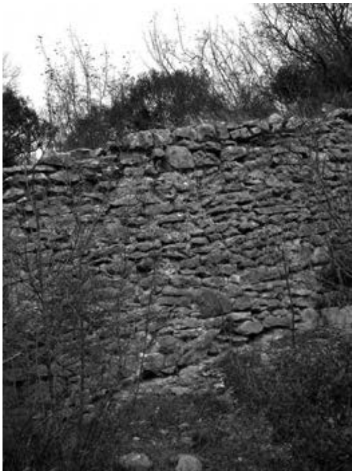
Foto 6 – Castello di San Giorgio, particolare della muratura orientale.
