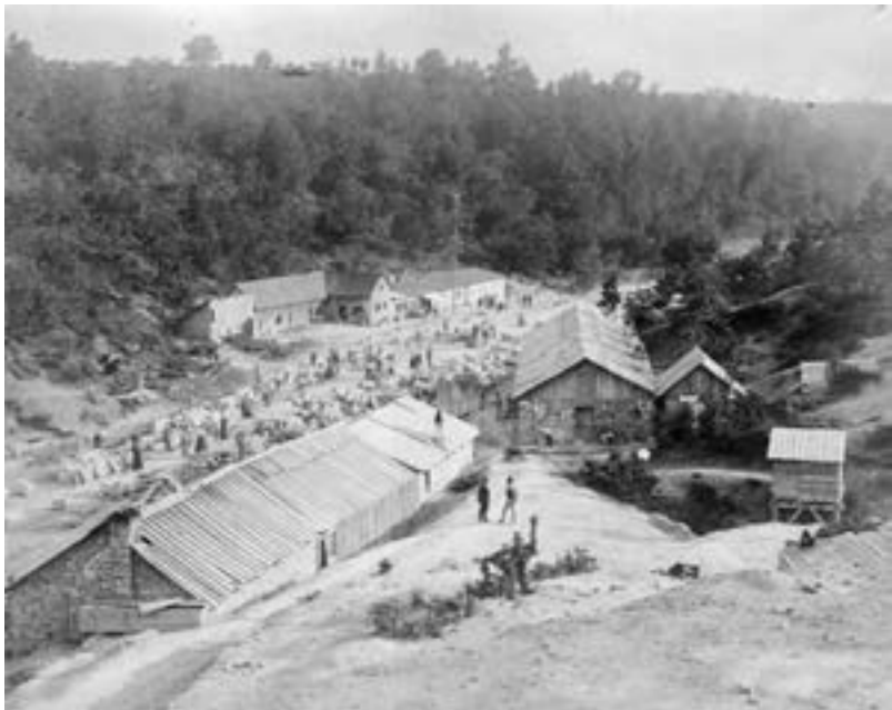
Fig. 2 – Costruzione della ferrovia Pola-Divaccia: cantiere di Borutto con numerosa presenza umana per il traforo della Galleria (collezione C. Pericin).
