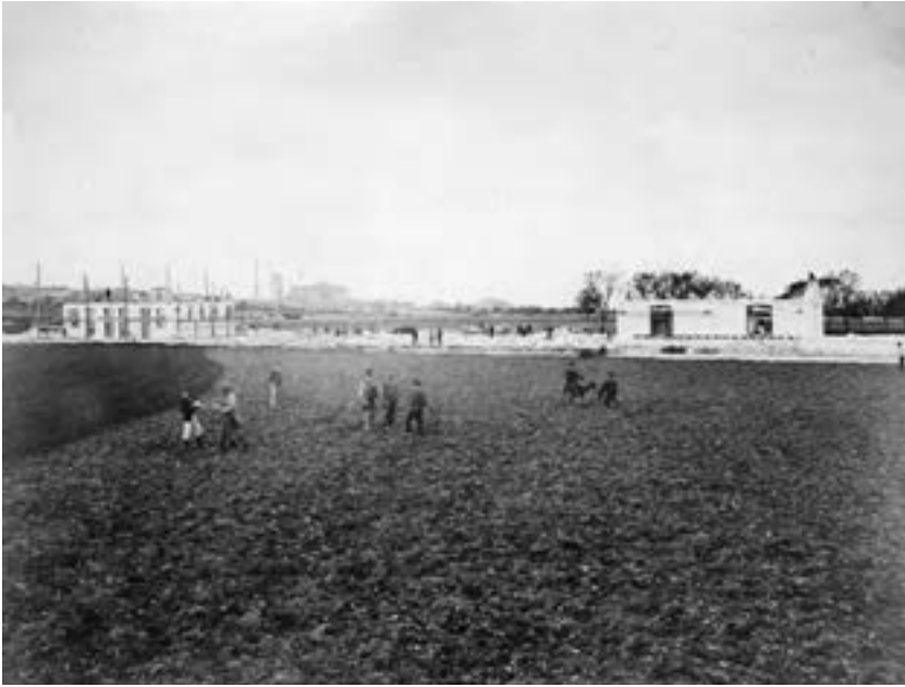
Fig. 3 – Costruzione della ferrovia Pola-Divaccia: cantiere di Dignano in grande attività (collezione C. Pericin).
