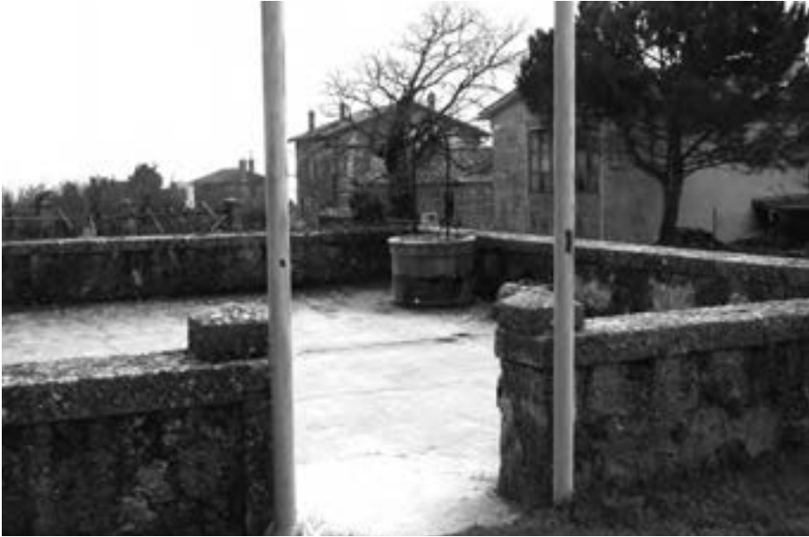
Fig. 11 – 2009: aspetto attuale della cisterna comunale a Diminici (foto C. Pericin)
