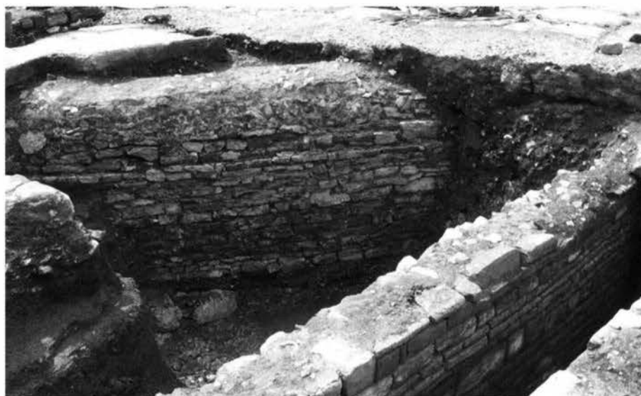
Fig. 5. – Pola, Foro, condotta fognaria ( cloaca )
