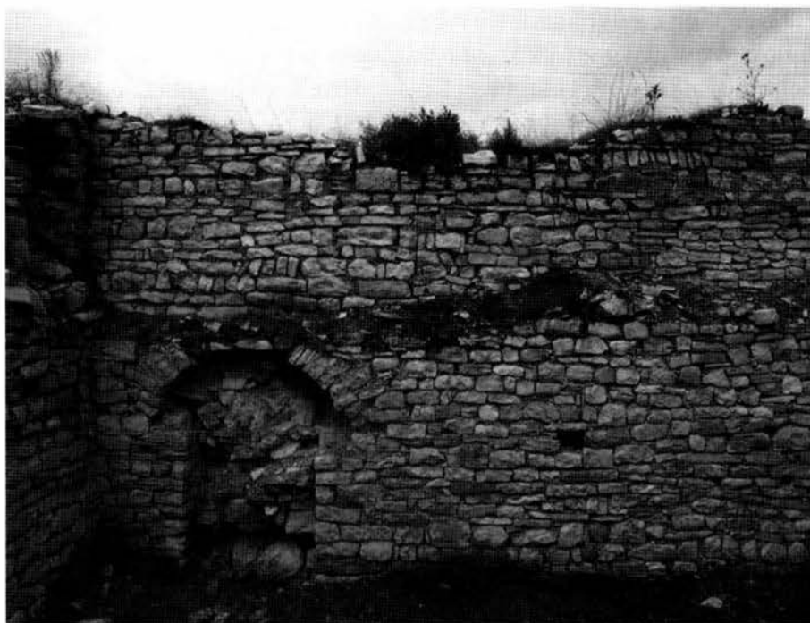
Fig. 7 – Particolare del prospetto interno meridionale con l'arco a fungo
