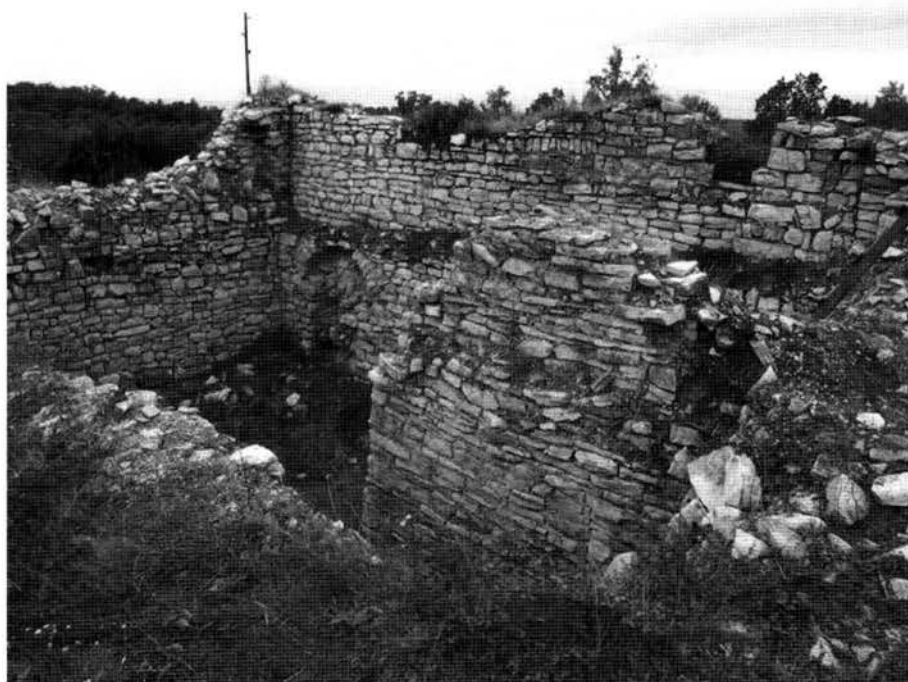
Fig. 5 – L'interno della torre
