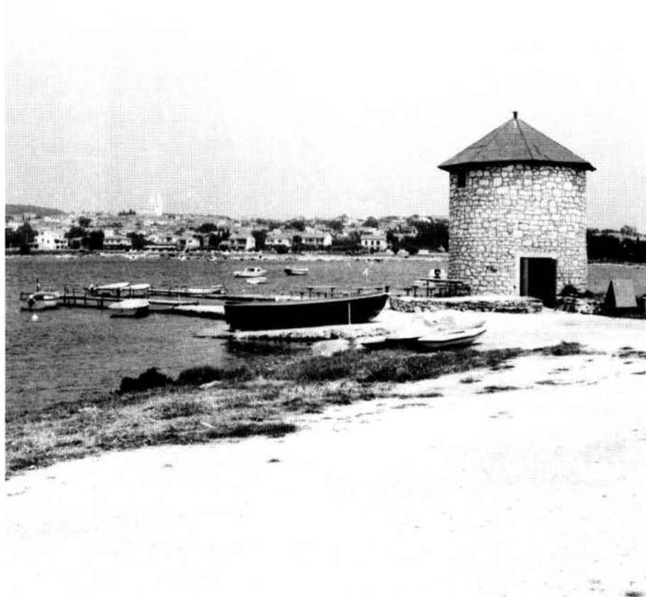
Fig. 21 – Vecchio edificio cilindrico del mulino a vento in porto Fontana (1990).
