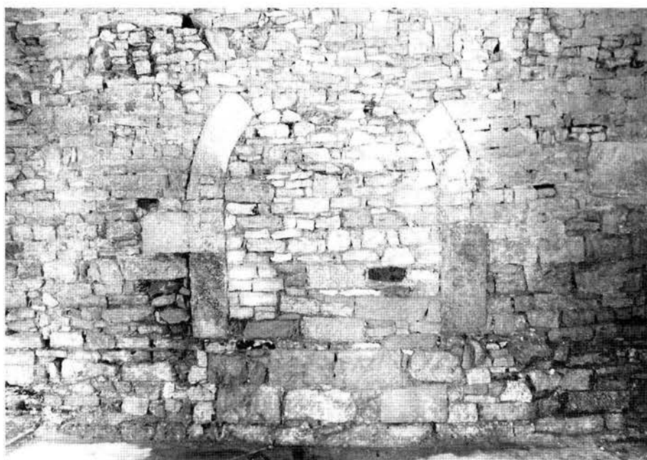
Fig. 6 – Muro interno della loggia, con resti di portale medievale romanico, murato dopo il secolo XVI.
