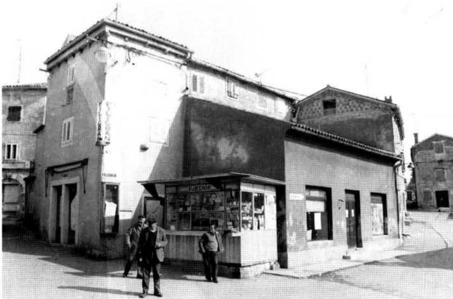
Fig. 8 – Torre e loggia devastate nel dopoguerra (foto anni '70 del secolo XX).
