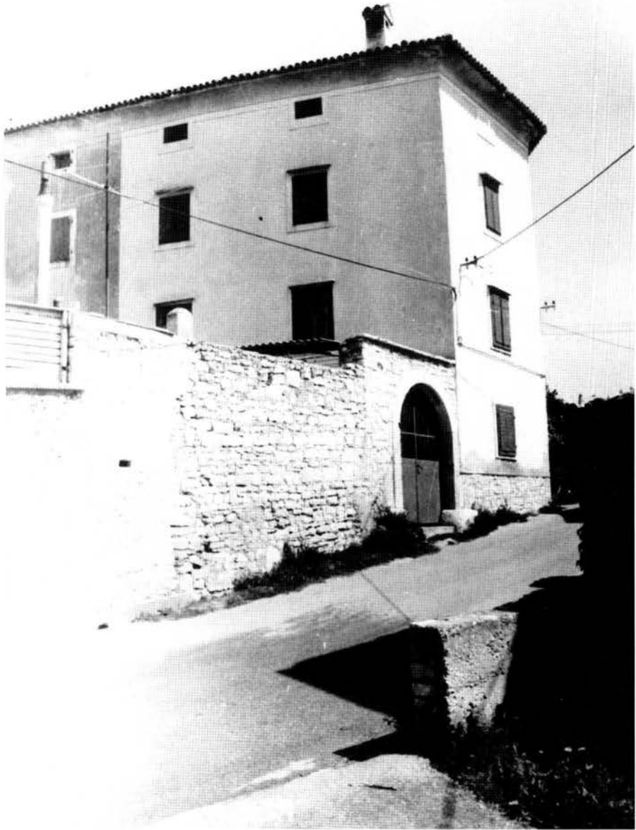
Fig. 24 – Palazzo "Vide", adiacente la chiesetta di S. Antonio.
