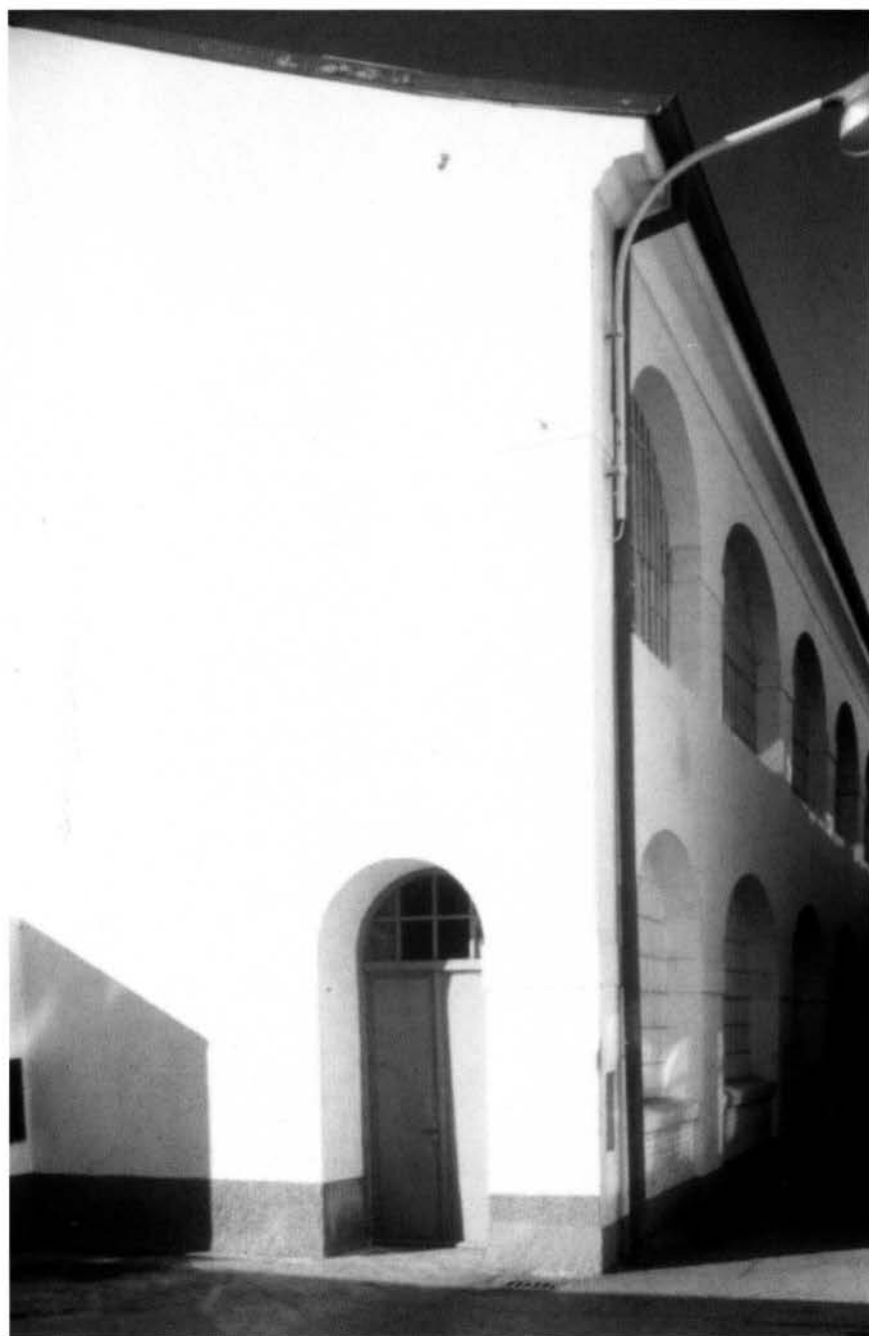
Fig. 14 L'edificio contumaciale, foto di D. Krizmanić.
