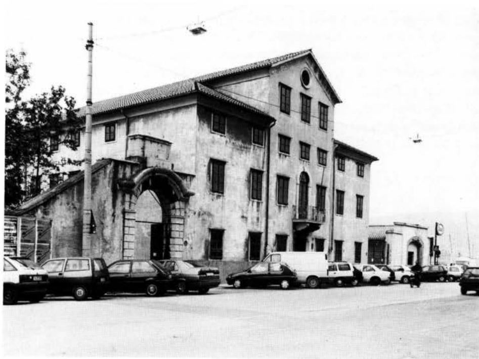
Fig. 20 – Il vecchio lazaretto triestino, edificio del priorato – stato attuale.
