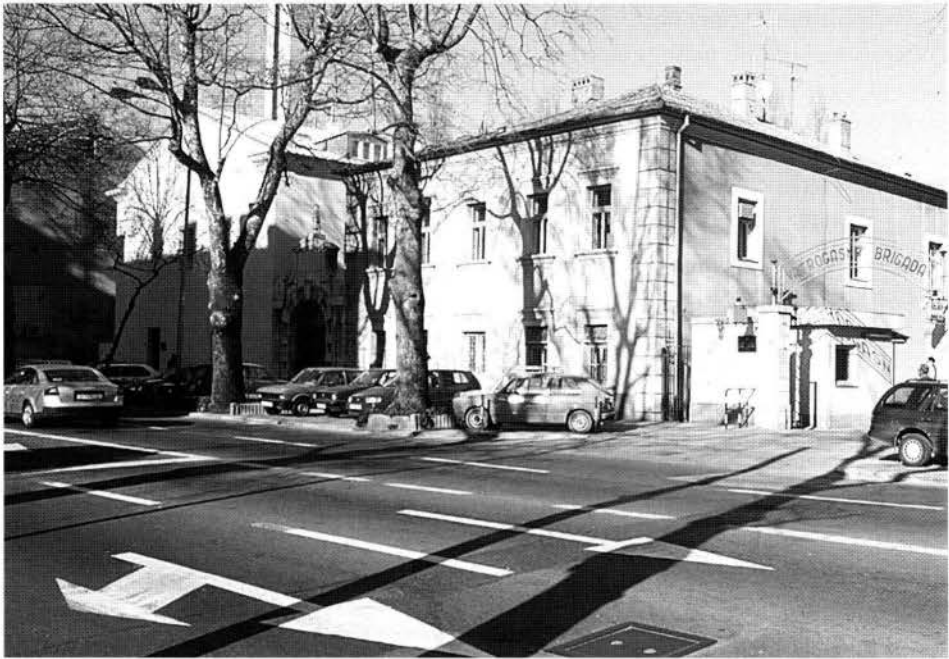
Fig. 21 – Il lazaretto di Fiume, facciata meridionale – stato attuale.
