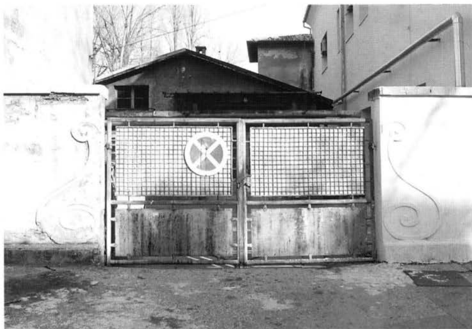
Fig. 16 – Portale occidentale litoraneo – stato attuale.
