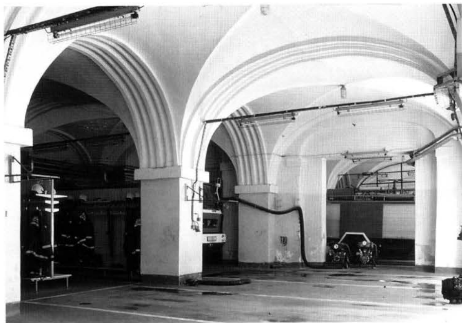
Fig. 18 – Magazzini, interno – stato attuale.
