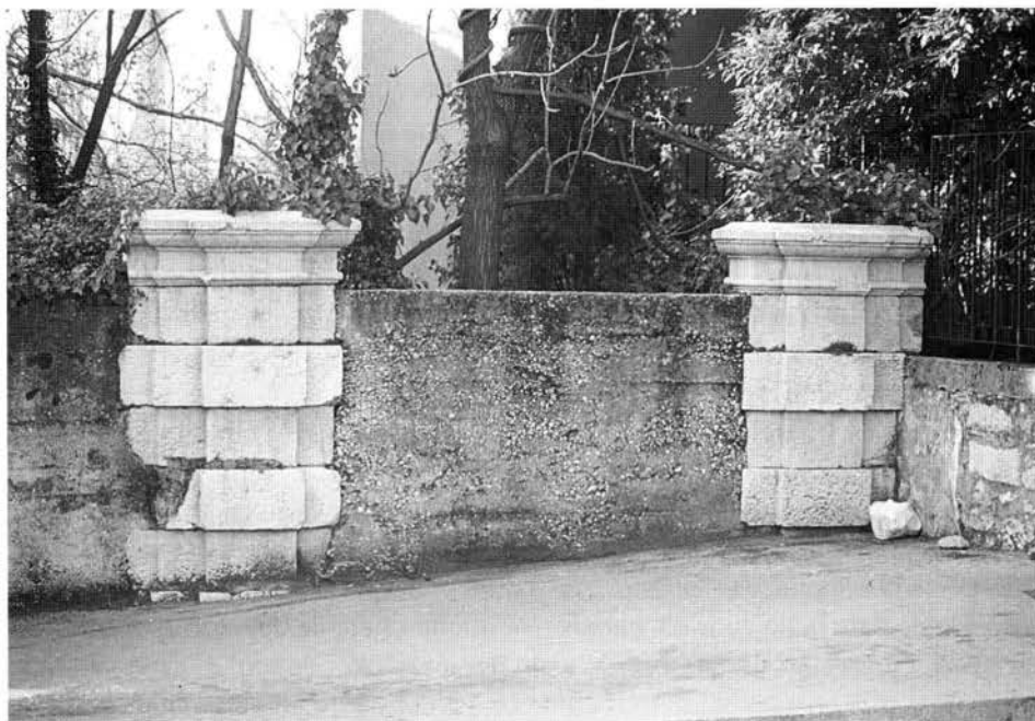
Fig. 5 – Portale settentrionale del lazzaretto – stato attuale.
