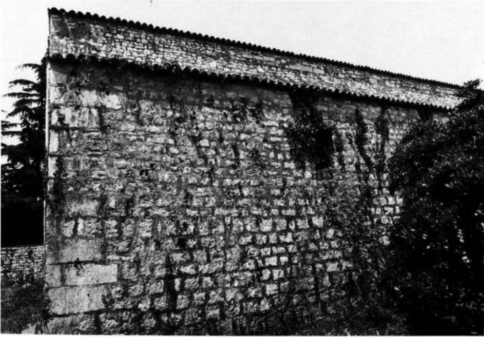
Fig. 12 – Chiesa di S. Maria - Orsera: dettaglio del muro meridionale.
