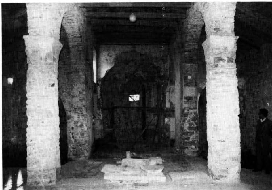
Fig. 20 – Chiesa di S. Agata nel cimitero di Cittanova: interno.
