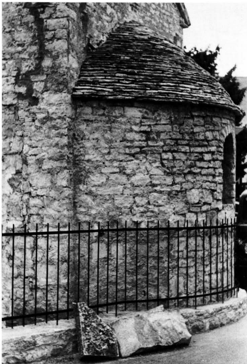
Fig. 18 – Chiesa di S. Agata nel cimitero di Cittanova: abside della navata principale.
