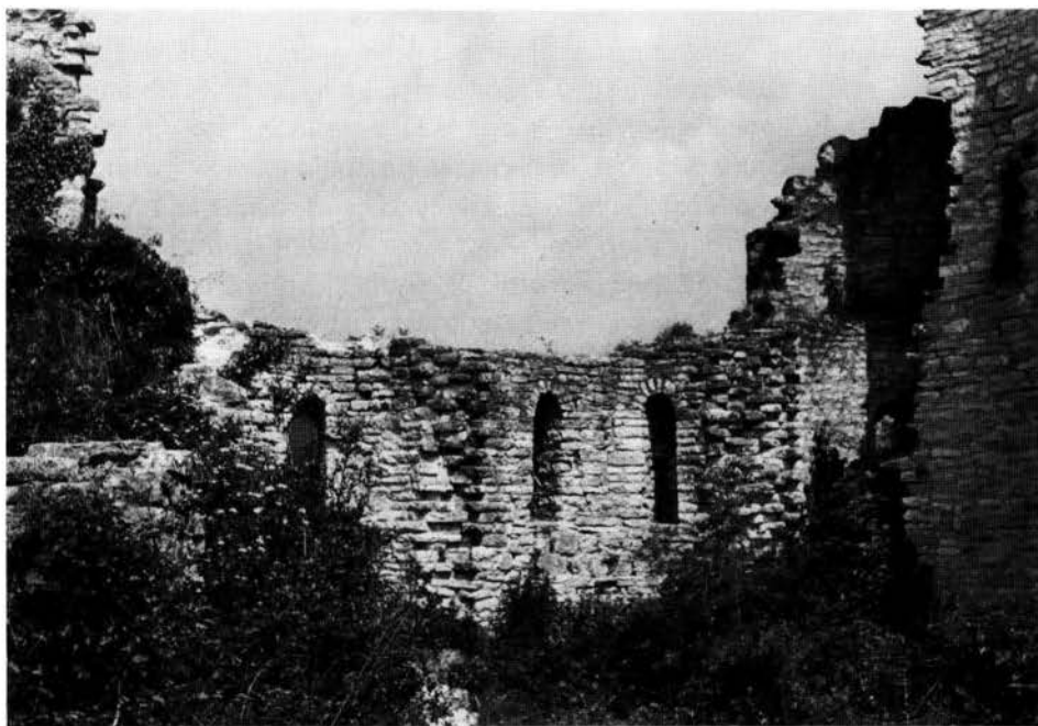
Fig. 8 – Chiesa di S. Sofia - Docastelli: parte absidale.
