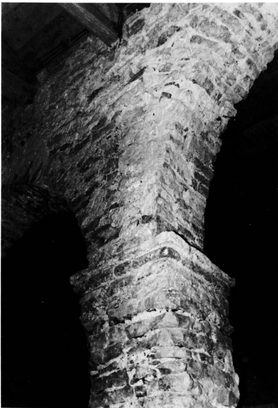
Fig. 21 – Chiesa di S. Agata nel cimitero di Cittanova: interno.
