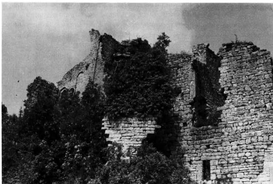
Fig. 9 – Chiesa di S. Sofia - Docastelli: dettaglio della facciata.
