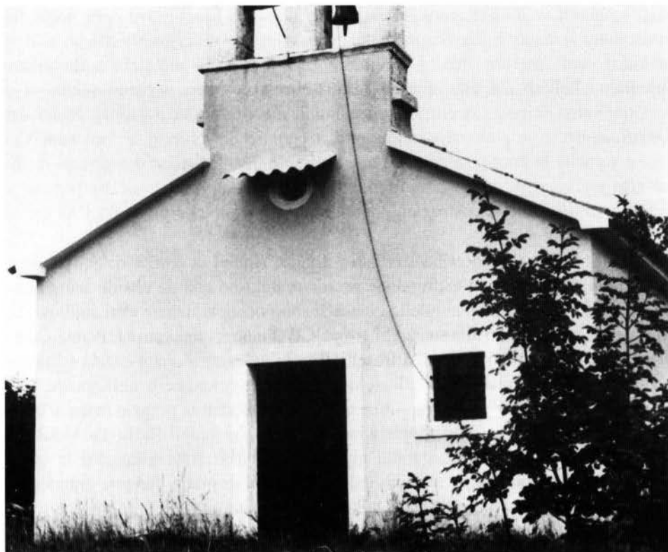
Foto 6 - Chiesa di S.Giorgio a Radovani — esterno.
