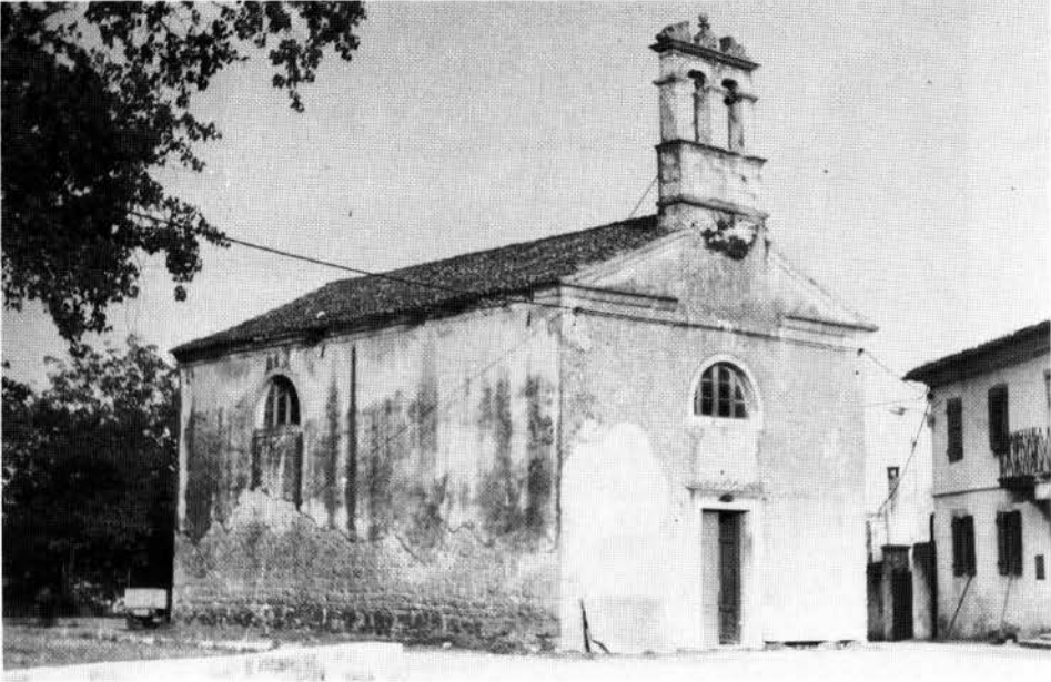
Foto 15 - Chiesa di S. Barnaba a Visinada – esterno. Foto di D.Demonja.
