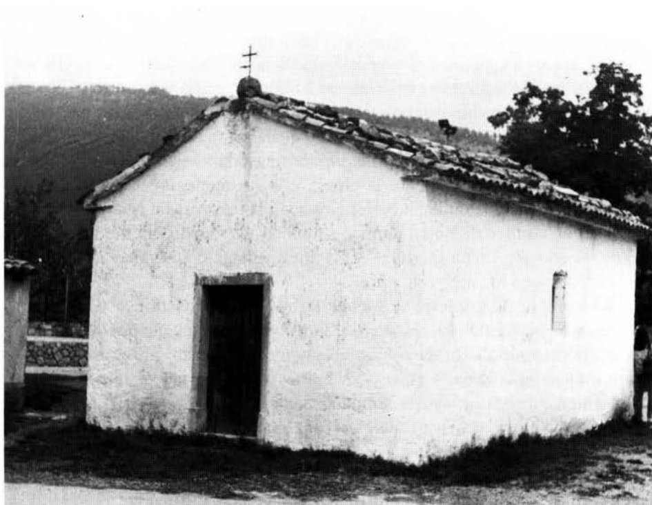
Foto 8 - Chiesa di S. Rocco a Rozzo - esterno. Foto di D. Demonja.
