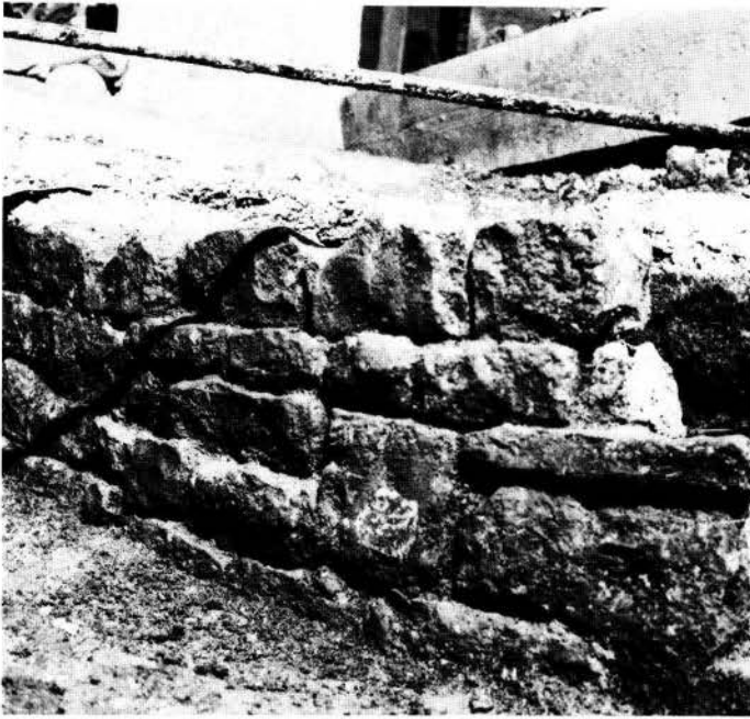
Fig. 13 - Resti del muro antico di Via Eufrasiana, 4 (A. Jugovac)
