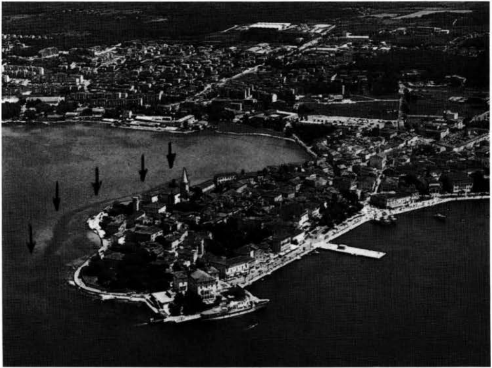
Fig. 3 - La parte settentrionale della città. Le freccette indicano i resti della Porporella, ossia della costruzione sotto la superficie del mare, per la quale si riteneva che rappresentasse i ruderi del porto romano.
