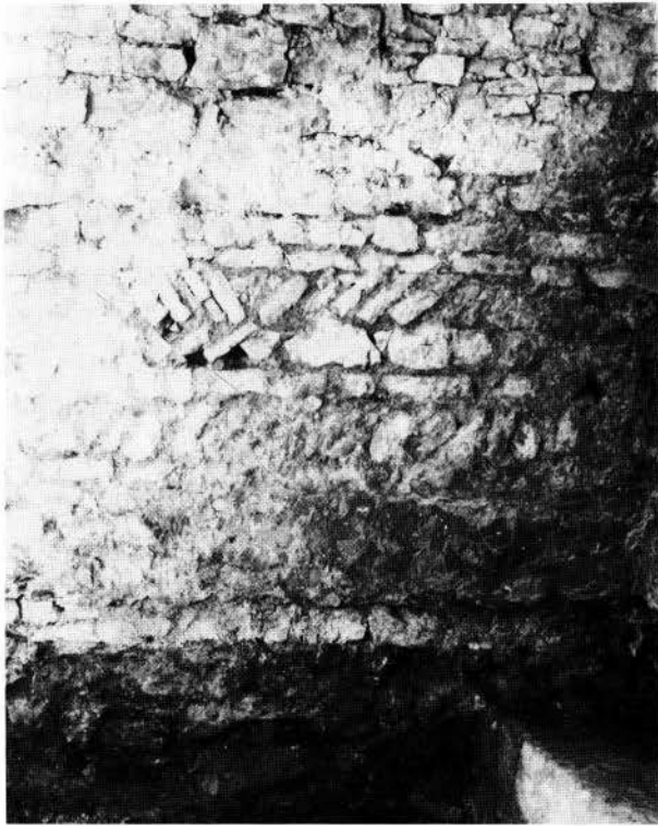
Fig. 10 - Dettaglio del muro di Via Eufrasiana, 26 (A. Jugovac).
