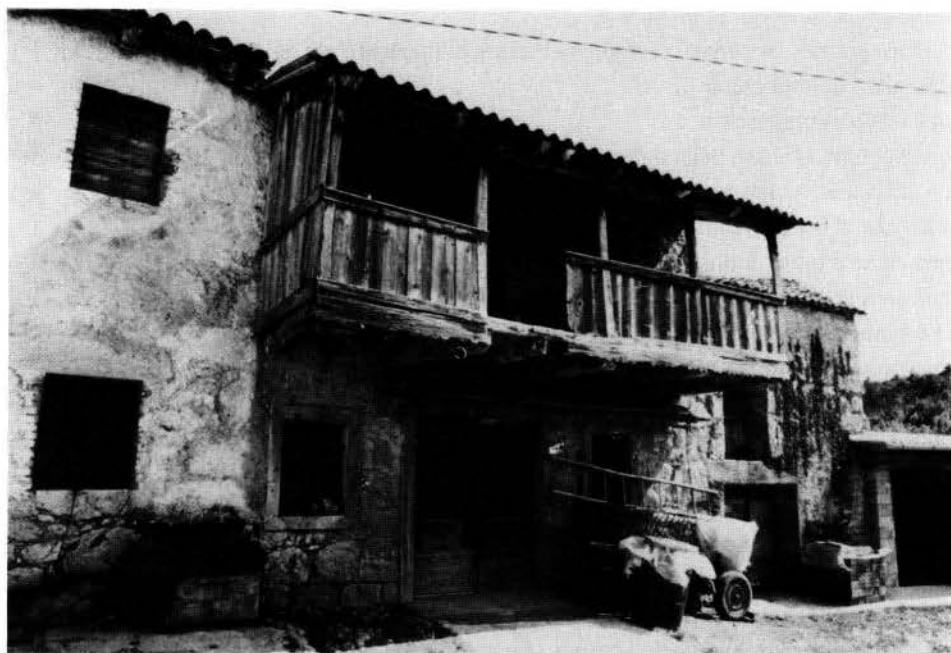
Fig. 19 - Casa di tipo 2D, con ballatoio di legno (Sasseto/Zazid, Decani).
