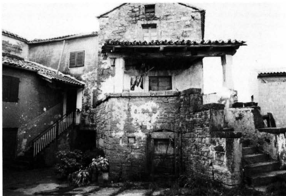
Fig. 1 - Casa di tipo 1A, con scala perpendicolare alla facciata, terrazzino con loggetta ad 1 spiovente e 2 pilastri (Loschici/Luskići, Pinguente).
