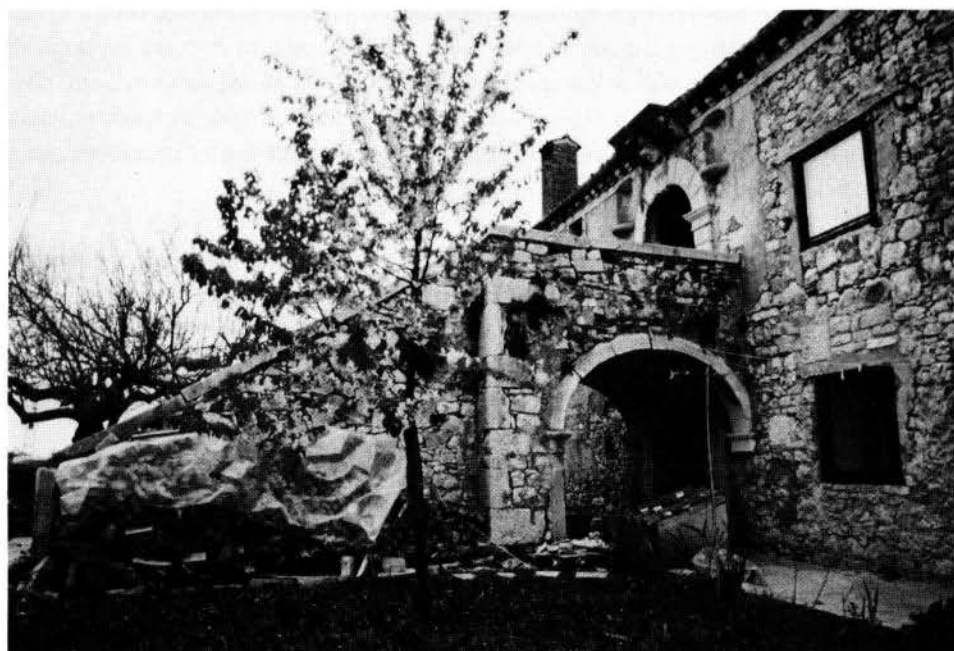
Fig. 8 - Casa di tipo 1A, con scala perpendicolare alla facciata e terrazzino con arco laterale (Monspinoso/Dračevac, Parenzo).
