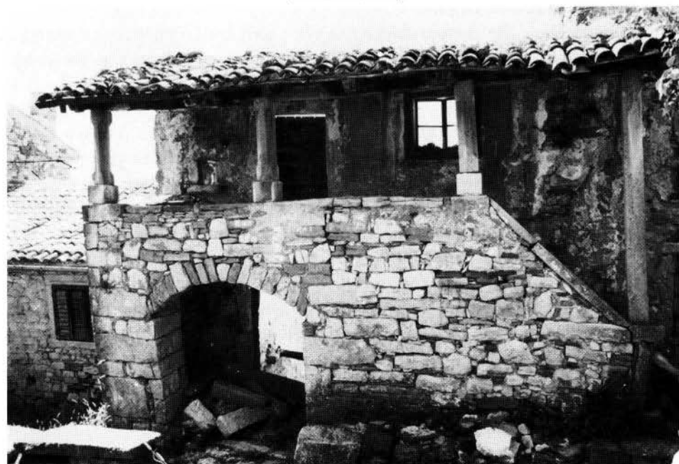
Fig. 2 - Casa di tipo 1A, con scala parallela, terrazzino con loggetta ad 1 spiovente e 3 pilastri e 1 pilastro (Colmo/Hum, Rozzo).
