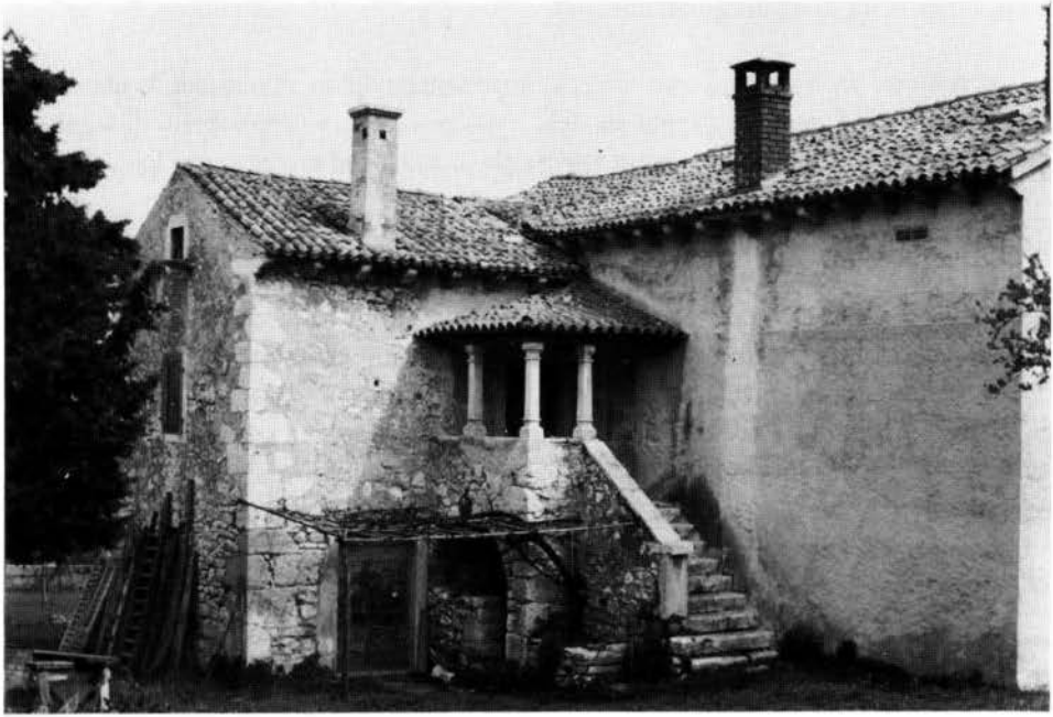
Fig. 5 - Casa di tipo 1A, con loggetta a 2 spioventi e 3 pilastri (Pomer/Pomer, Pola).
