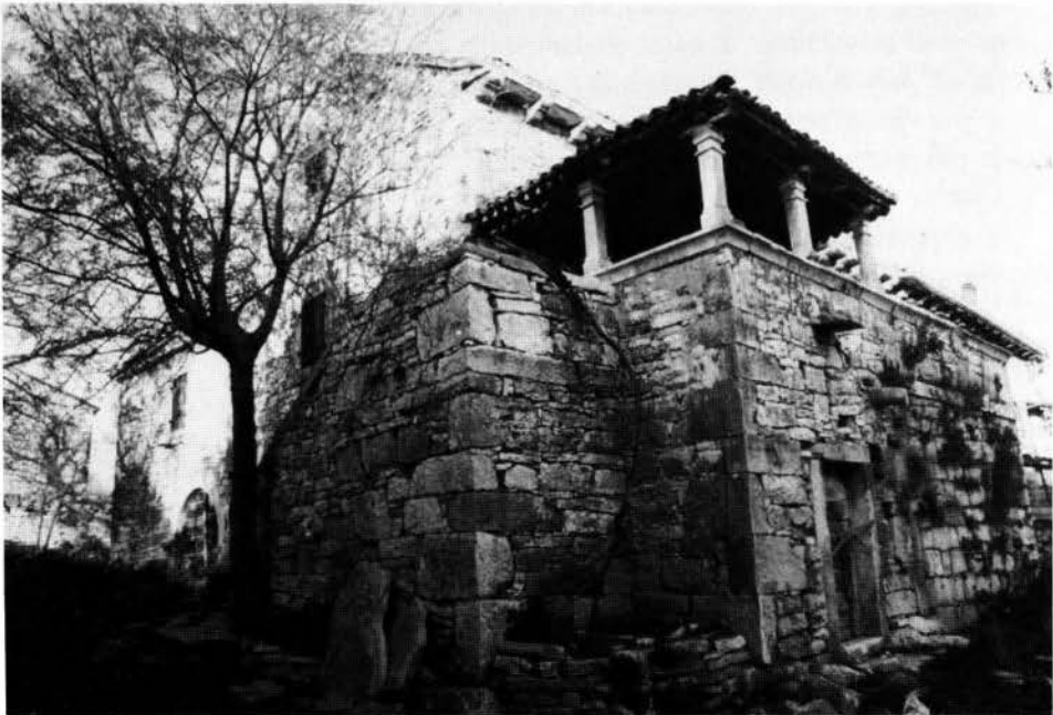
Fig. 6 - Casa di tipo 1A, con scala parallela ad un muro laterale, terrazzino con cisterna, loggetta a 3 spioventi e 5 pilastri (Ierachi/Heraki, Orsera).
