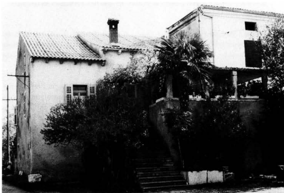
Fig. 4 - Casa di tipo 1A, con scala perpendicolare alla facciata, terrazzino con cisterna, loggetta ad 1 spiovente e 6 pilastrini (Radolovi/Ladrovići, Parenzo)
