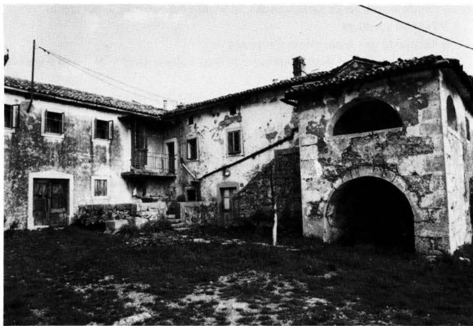
Fig. 9 - Casa di tipo 1A, con scala parallela, terrazzino chiuso con aperture ad arco (Bergud Grande/Veli Brgud, Castua).
