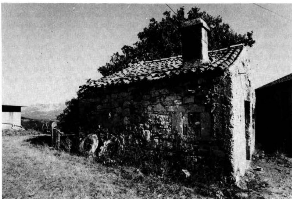
Fig. 24 - Casa monocellulare, con focolare e camino (Florici/ Floričići, Pisino).
