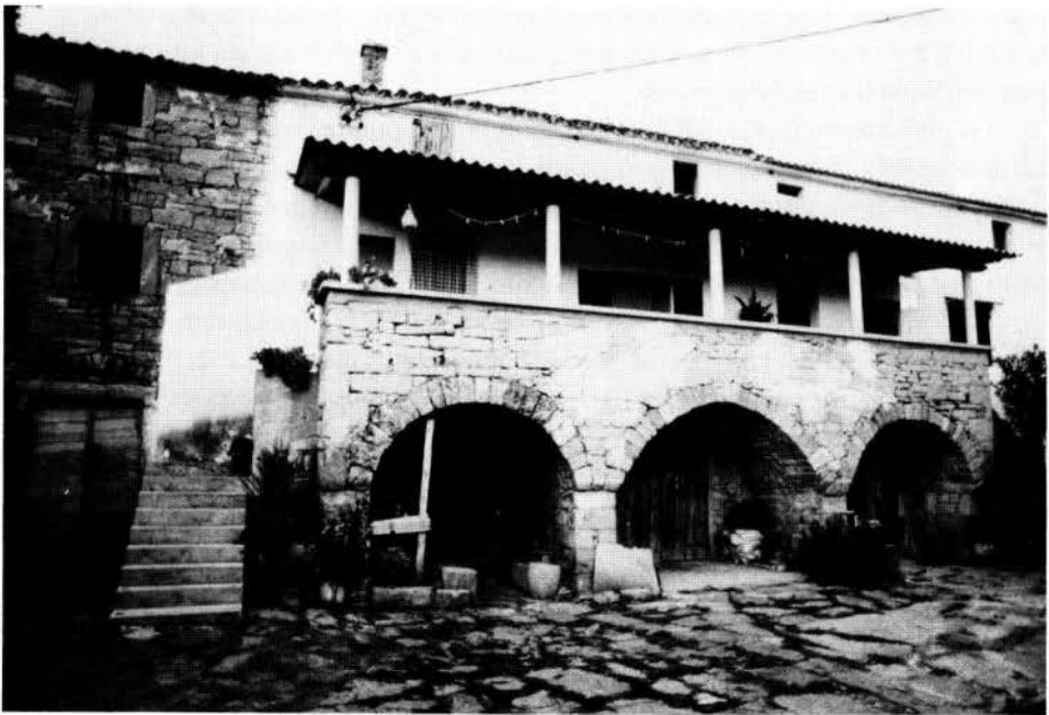
Fig. 12 - Casa di tipo 1A, con terrazzino a tripla arcata - la loggetta con 5 pilastri è un rifacimento recente (Saberda/Zabrda, Pinguente).
