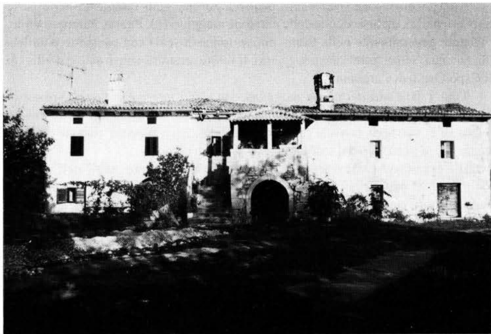
Fig. 3 - Casa di tipo 1A, con scala perpendicolare, terrazzino con loggetta a 3 spioventi e 5 pilastrini (Iecnici/Jehnici, Parenzo).
