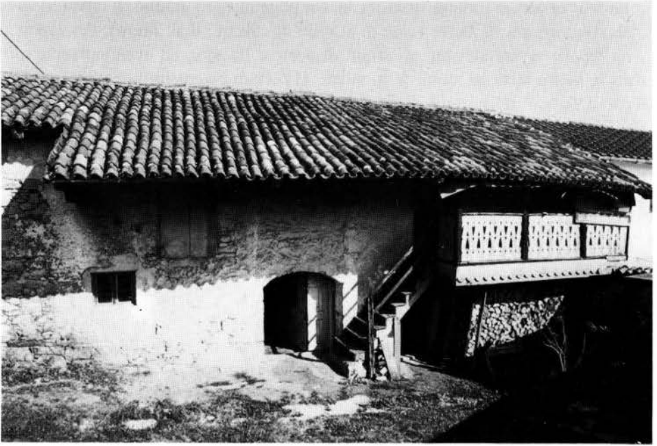
Fig. 21 - Casa di tipo 2D, con ballatoio di legno e scala esterna (Sappiane/Šapjane, Elsane).
