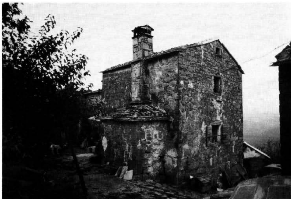
Fig. 13 - Casa di tipo 2B, con vano del focolare rettangolare sulla facciata posteriore (Benigni/Beninici, Portole).
