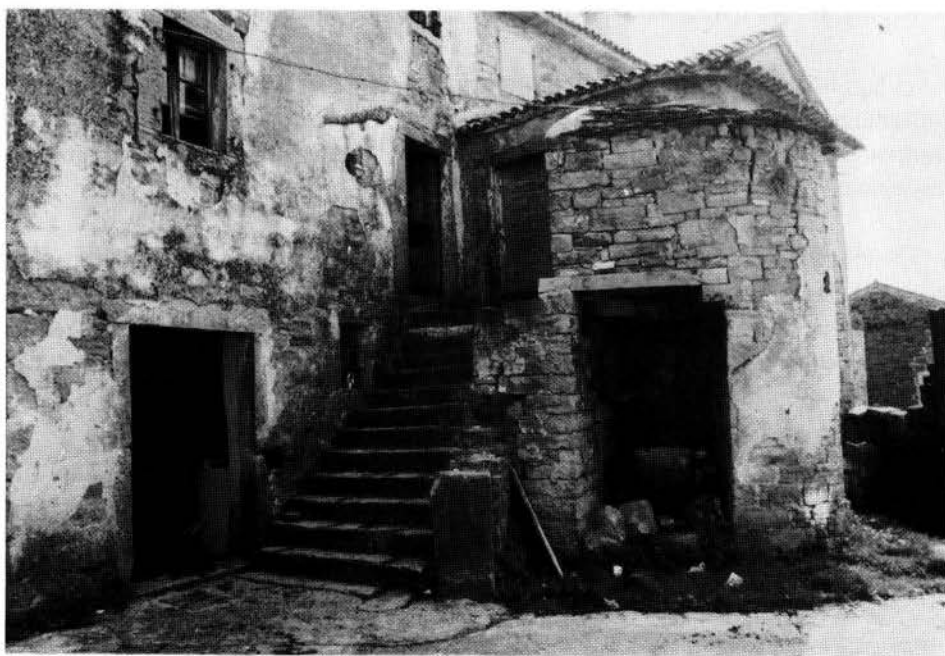
Fig. 10 - Casa di tipo 1A, con scala parallela, terrazzino con forno per il pane (Oscurus/ Skorusica, Buie).
