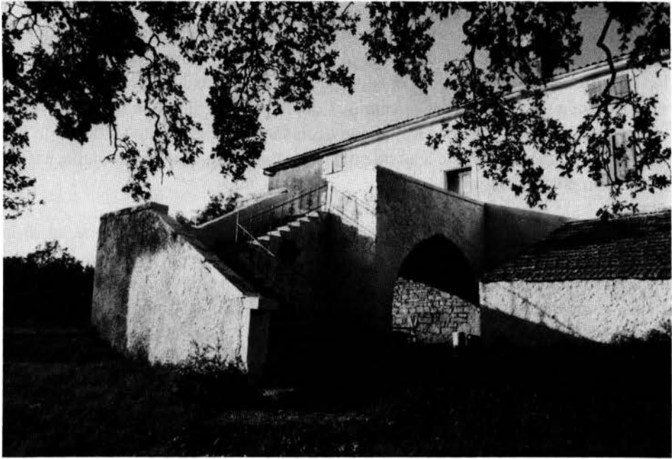
Fig. 11 - Casa di tipo 1A, con scala a forma di L e terrazzino con arco laterale (Stanzia Radovan/ Stancija Radovan, Parenzo).
