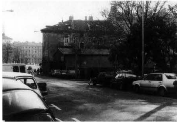
Fig. 12 - La continuazione della Via Martiri del Fascismo: è il possibile tracciato del tragitto antico oltre la Fiumara.
