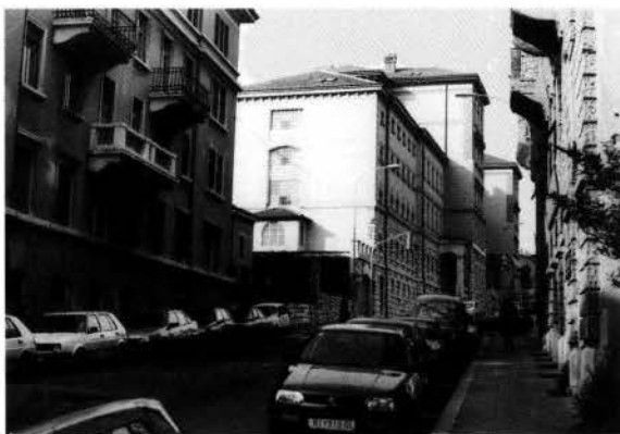
Fig. 9 - Centro del frons settentrionale della città medievale e antica: l'edificio del Tribunale al posto del Castello medievale.
