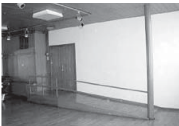
Slika 2. Pristupna rampa u estetskoj gimnastičkoj dvorani
