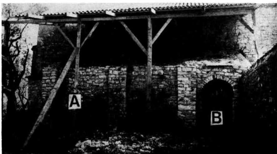
FIG. 10 - S. Michele di Leme, superficie esterna del muro settentrionale della chiesa più piccola con l'ingresso 4 chiuso (A) e l'ingresso 5 (B).
