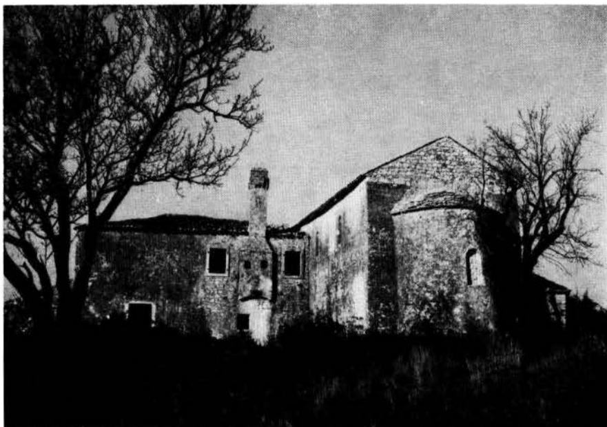
FIG. 5 - S. Michele di Leme, veduta generale del complesso architettonico.
