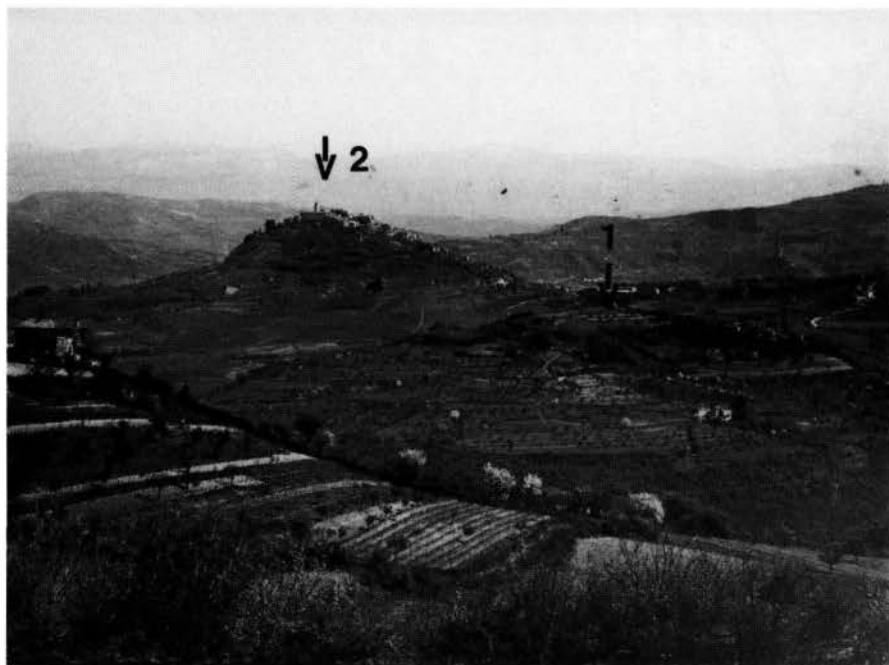
FIG. 2 - Veduta di Vrh presso S. Pancrazio (1) e di Montona (2).
