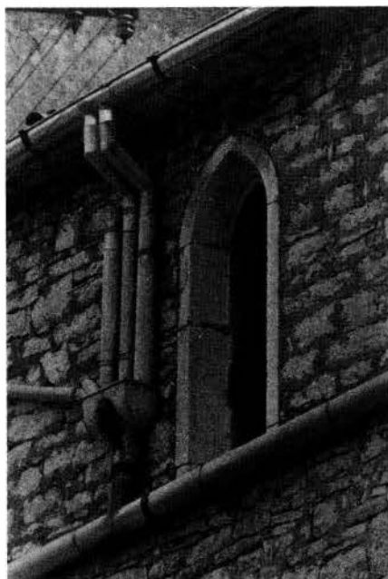
7 - Valle. Finestra gotica a sesto acuto riutilizzata nella facciata settentrionale della nuova chiesa (1879-1882).
