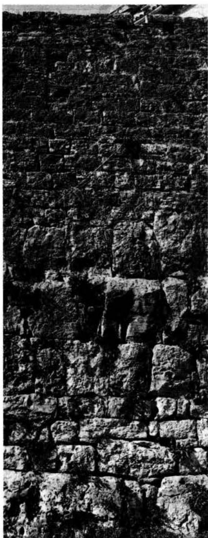
2 - Valle. Facciata della torre a sud della chiesa parrocchiale.
