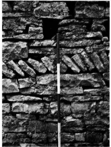
14 - Basilica Madonna Alta presso Valle. Struttura del muro longitudinale settentrionale.
