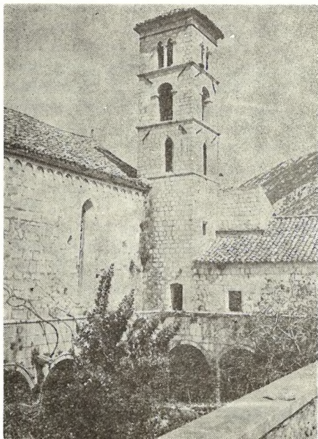
1. Crkva i samostan franjevaca, Ston
