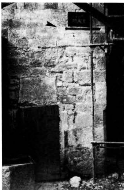
2 - Albona, pilastrino preromanico (?) murato come spoglio nella facciata della chiesa parrocchiale.
