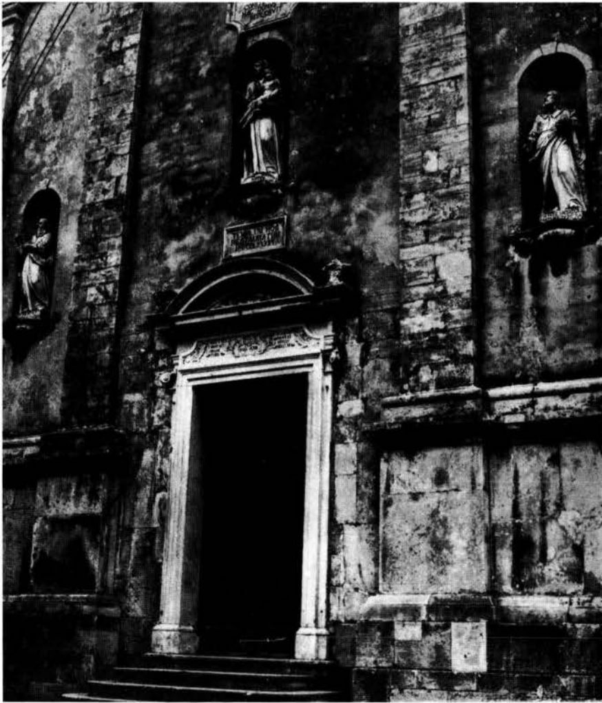
14 - Antignana, facciata della chiesa parrocchiale.
