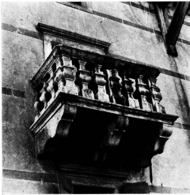
16 - Visinada, balcone di edificio barocco, nei pressi della cisterna.
