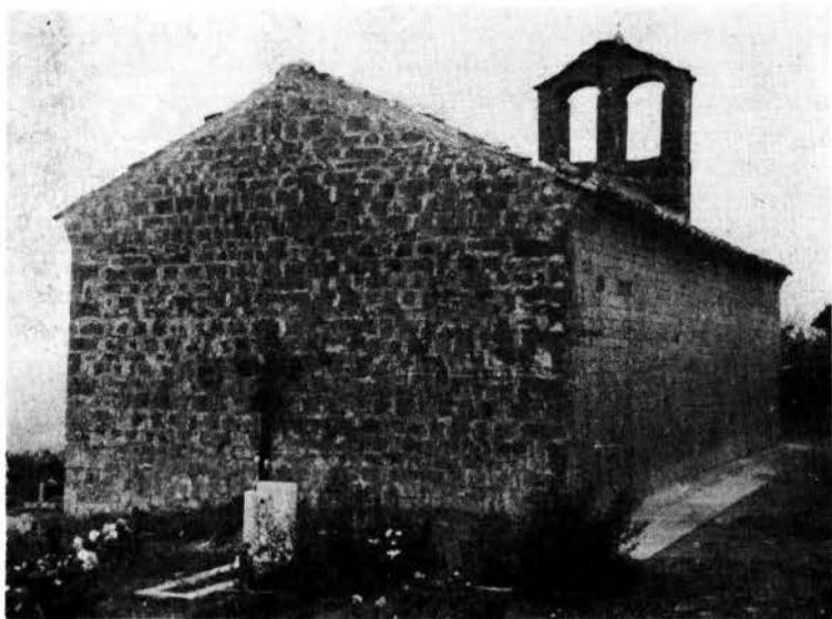
52 - Colmo, cappella cimiteriale di S. Gerolamo - muro di fondo e muro settentrionale.
