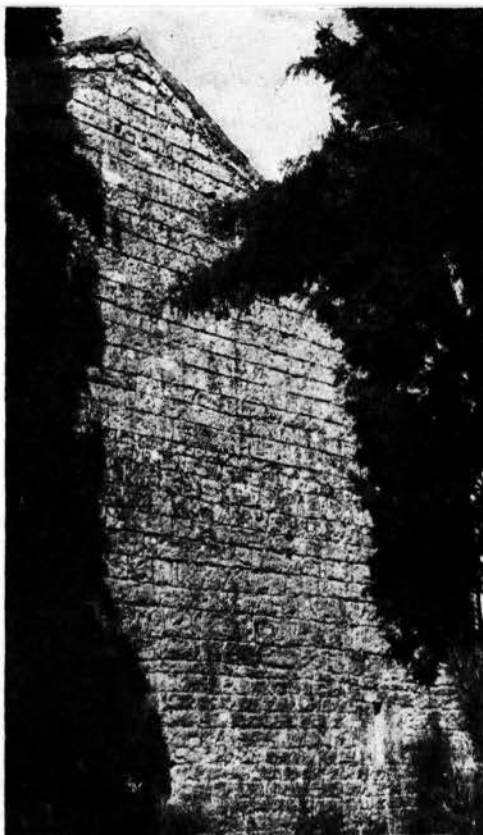
104 - Sanvincenti, cappella cimiteriale di S. Vincenzo - muro di fondo.
