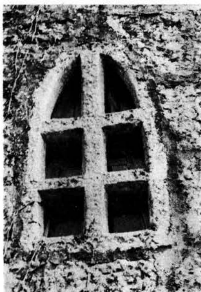
56 - Due Castelli, cappella cimiteriale di S. Maria del Lacuccio - transenna finestrale nel muro settentrionale.
