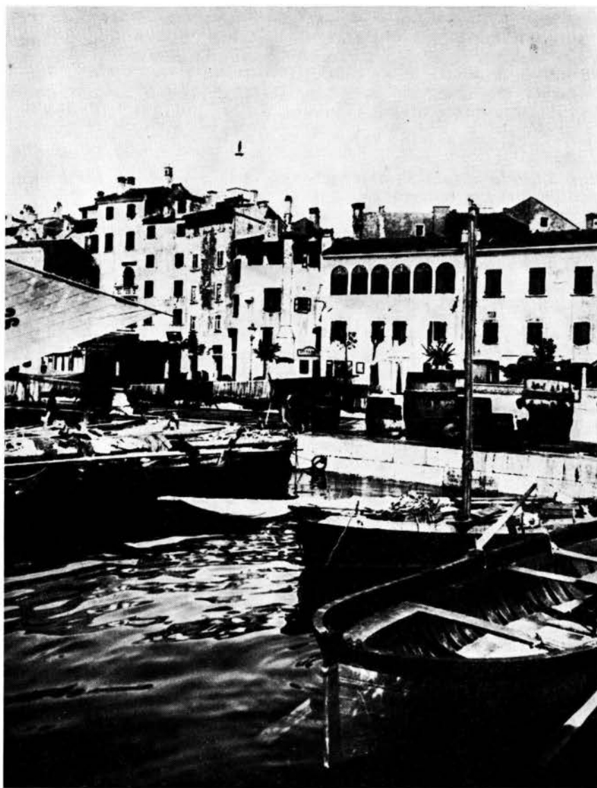
3 - Riva Sottomuro con veduta di parte della Loggia del Palazzo Comunale demolita nel 1912 come nella foto 2. (Foto Museo Civico di Rovigno)
