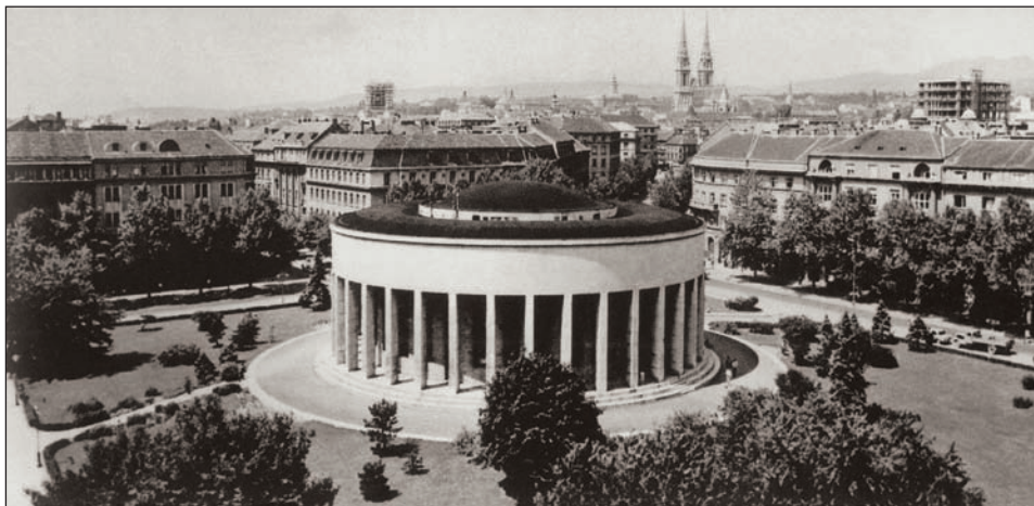
Slika 9. Dom likovnih umjetnosti. I ta zgrada dobila je Meštroviću omiljeni centralni oblik klasičnog stila. Trijem oko zgrade nosi niz četvrtastih stupova smirenog ritma. Čistoća rješenja odiše antičkim idealima ljepote. Fototeka Galerije Meštrović: inv. br. FGM-4593.
