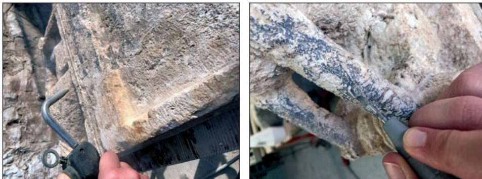
Slike 16. i 17. Čišćenje kamena steamerom i ultrazvučnom iglom (fotografirala Ivana Duvnjak)
