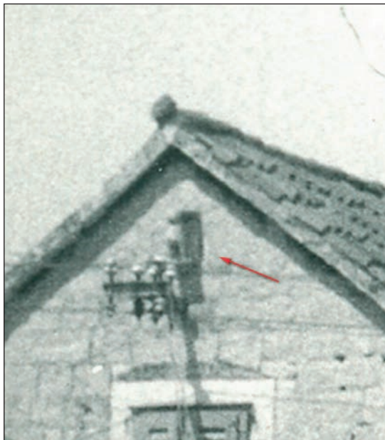
Slika 2. Mjesto gdje je bila ugrađena ranoromanička kamena konzola
