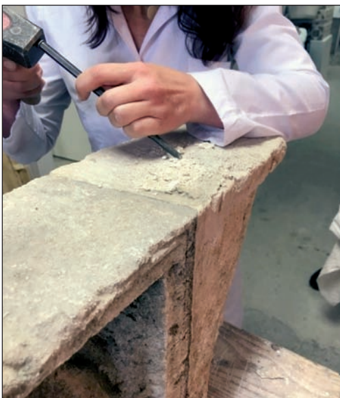
Slike 12. i 13. Suho čišćenje dlijetom (lijevo) i suho čišćenje skalpelom (desno) (fotografirala Ivana Duvnjak)
