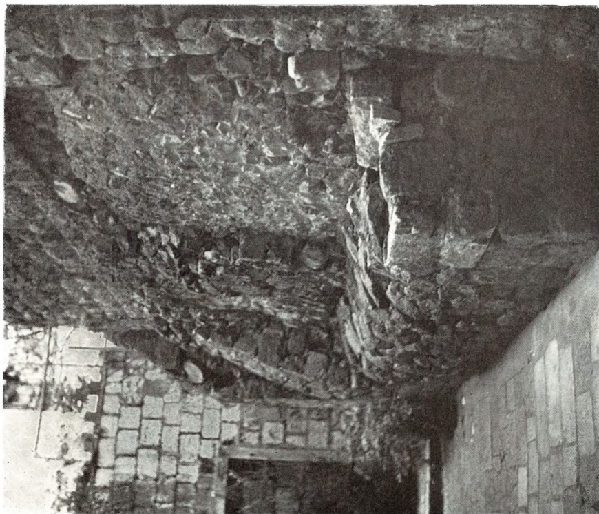
Slika 2 — Ostaci sjevernih zidina prvotnog Dubrovnika ( ulica Petarica )
