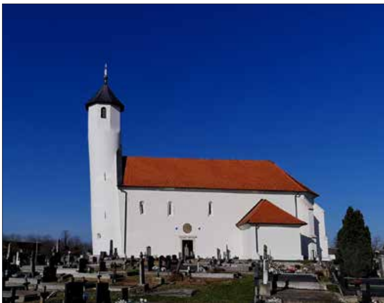
Sl. 2. Novi Mikanovci - crkva sv. Bartola, pogled s juga nakon završetka zaštitnih radova obnove 2020., foto: R. Ivanušec, fototeka MKRH - KOV
