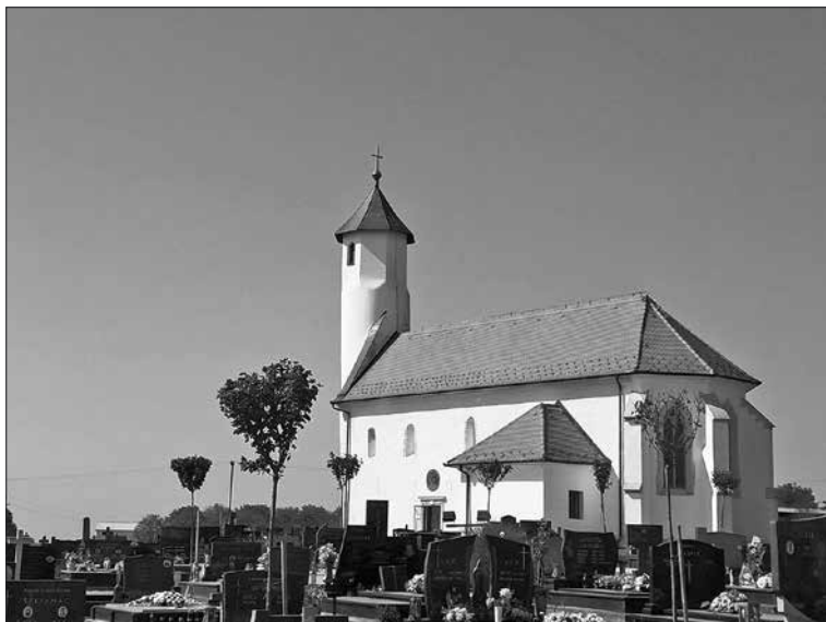
SI. 20. Novi Mikanovci - crkva sv. Bartola nakon završetka zaštitnih radova obnove, pogled s jugoistoka, foto: R. Ivanušec, 2020.
