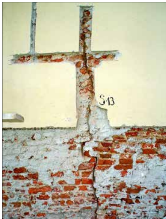
SI. 5. Novi Mikanovci - crkva sv. Bartola, konzervatorsko istraživanje - spojna graditeljska reška na južnom zidu broda crkve (zapadna dogradnja romaničke crkve), foto: R. Ivanušec, 2007.
