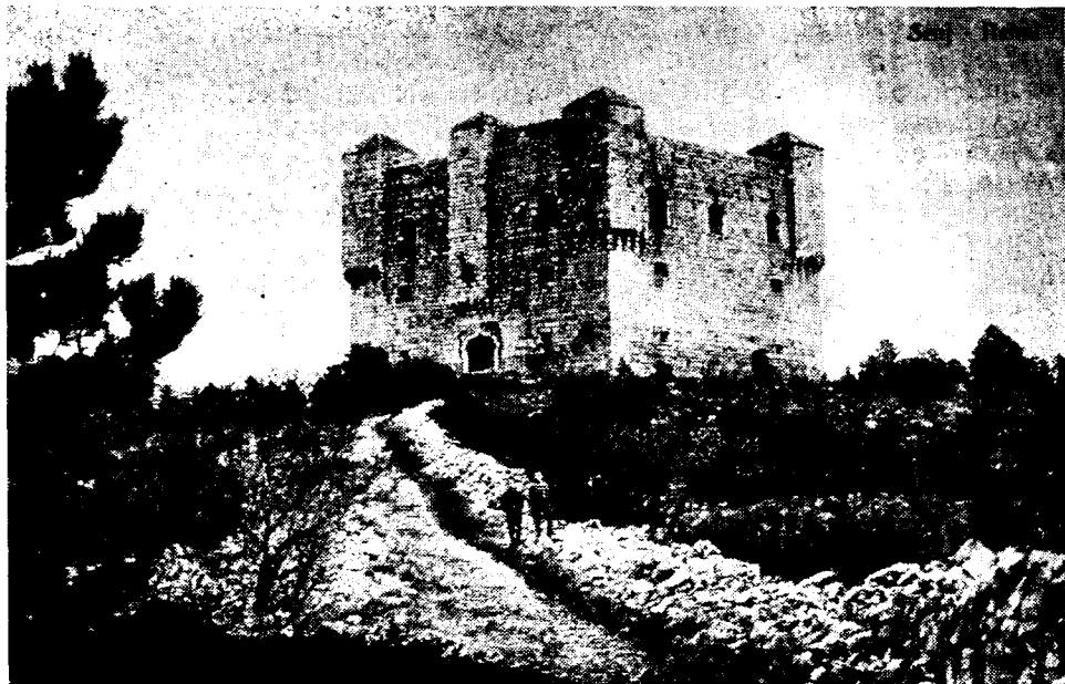
Sl. 94. — Senjska tvrđava Nehaj, sagrađena g. 1558. na istoimenom brdu — Južno i zapadno od Nehaja utvrđeno je veliko rimsko groblje sa spaljenim ostacima pokojnika (slika iz god. 1900)
