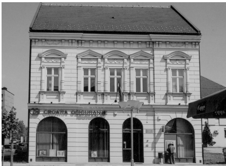
➡ SLIKA 2 Vukovar, zgrada "Croatia osiguranja": obnova metodom faksimila [foto: Z. Karač, 2007.]
