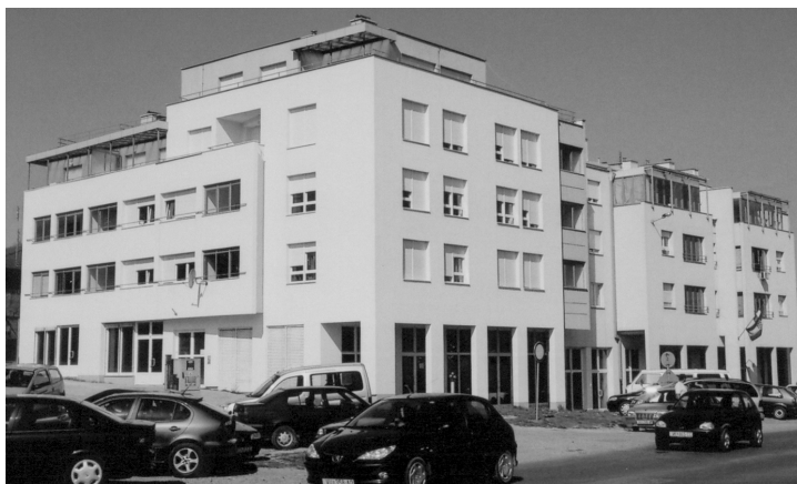
➡ SLIKA 3 Vukovar, stambeno- poslovne zgrade u Frankopanskoj ulici: obnova metodom suвременe interpolacije [foto: Z. Karač, 2007.]
