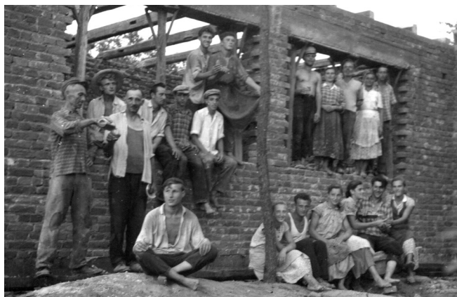
Sl. 3. Trenutak odmora prilikom izgradnje nove školske zgrade i društvene sale, 27. 8. 1960. godine. Ispred buduće sale sasvim lijevo stoje majstori Marko Kokša i Franjo Žagar (Spomenica škole Gornja Šuma, 1946. – 1983.).
