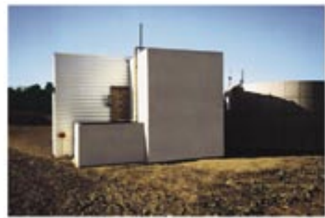
Uređaj s anaerobnom razgradnjom
