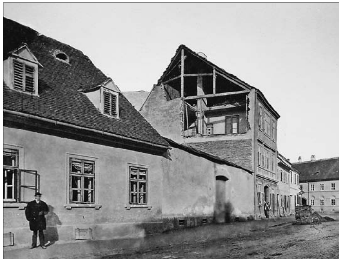
SL. 13. MAROVSKA (DANAS MASARYKOVA) ULICA NAKON POTRESA 9. 11. 1880. ZGRADA KOJOJ SE URUSIO ZID STOJI I DANAS U MASARYKOVOJ 6 (FOT. IVAN STANDL, 1880.).
