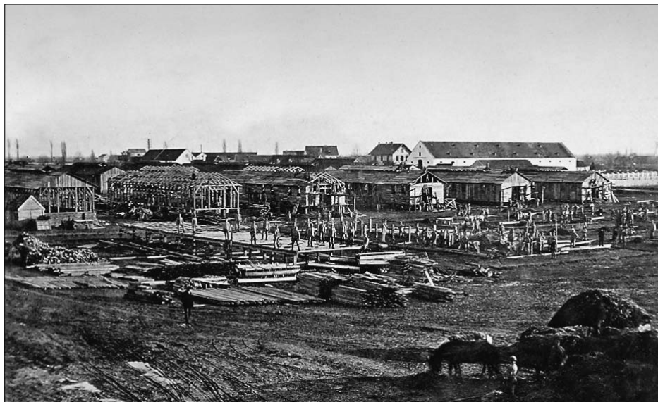
SL. 16. IZGRADNJA VOJNIH BARAKA NA CIGLANI (FOT. HERMANN FICKERT, 1880.)
