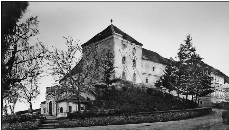
SL. 11. POPOV TORANJ NAKON POTRESA. U POZADINI SE VIDI PALAČA ERDÖDY-DRASKOVIĆ, DANAS DRŽAVNI ARHIV U ZAGREBU, PODUPRTIH ZIDOVA ZBOG OŠTEĆENJA U POTRESU (FOT. IVAN STANDL, 1880.).
