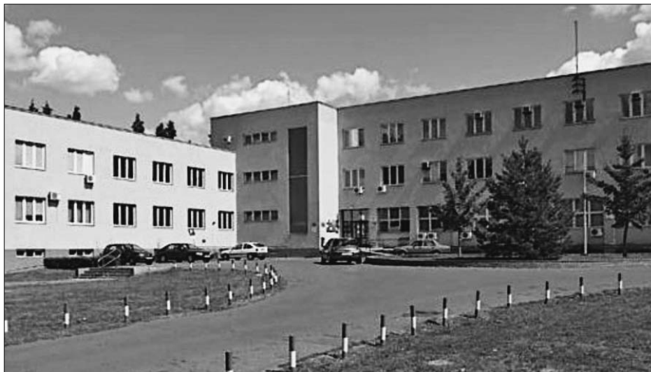
SL. 12. BELA AUER I ZVONIMIR VRKLIJAN: OKRUŽNI URED ZA OSIGURANJE RADNIKA U OSIJEKU, DANAŠNJI IZGLED FIG. 12 BELA AUER AND ZVONIMIR VRKLIJAN: DISTRICT OFFICE FOR WORKERS' INSURANCE IN OSIJEK NOWADAYS
