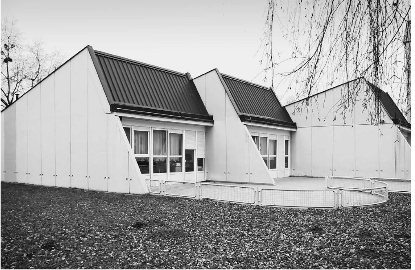
FIG. 1 PREFABRICATED CONCRETE KINDERGARTEN BUILDING CONSTRUCTED IN 1980'S IN SLOVENIA SL. 1. PREFABRICIRANA BETONSKA ZGRADA DJEČJEG VRTICA IZGRAĐENA 1980-IH GODINA U SLOVENIJI
