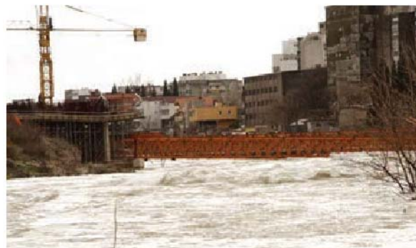
Slika 7. Gradilište Novog mosta 2010. godine [11]
