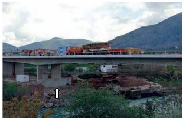
Slika 9. Zaštita desne obale kod riječnog stupa Novog mosta na Neretvi [11]
