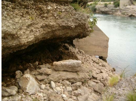
Slika 14. Podlokani sloj konglomerata sklon obrušavanju
