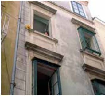
25 Projekt 33: demontaža prozorskih istaka („žburtova“) s drugog kata zgrade
