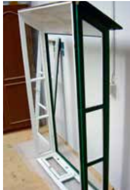
26 Projekt 33: obnova prozorskih istaka („žburtova“) u stolarskoj radionici
