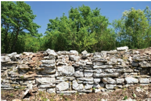
Sl. 12 Pogled na zazidani otvor na južnom zidu crkve (fotografija: J. Višnjić). Fig. 12 View of the walled-up opening in the south wall of the church (photo by: J. Višnjić).
