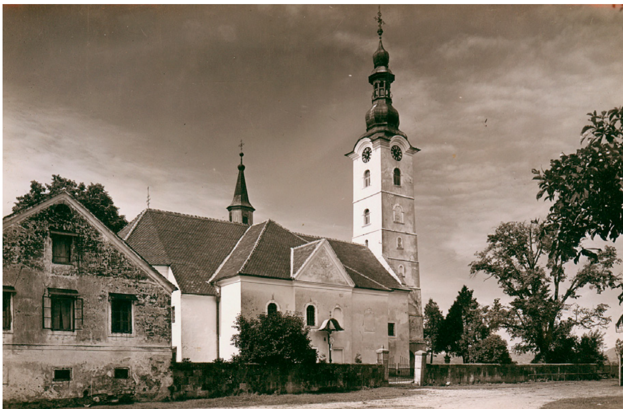
1. Brdovec, župna crkva sv. Vida, pogled na sjeverno pročelje (HAZU SFA, Lj. Griesbach, 1932.) Brdovec, parish church of St. Vitus, view of the northern façade (HAZU SFA; Lj. Griesbach, 1932)
