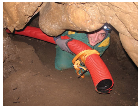
Slika 9. Provlačenje cijevi za ventilaciju zadnje dvorane Foto: Morena Želle
