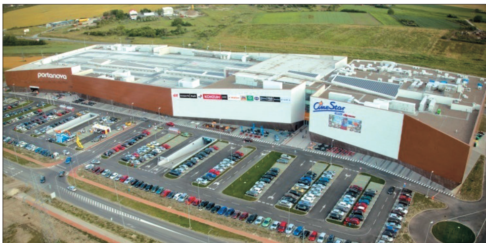
Slika 5. Fotografija trgovačkoga centra Portanova , Osijek (izvor: Arhiva trgovačkog centra Portanova , Osijek)
