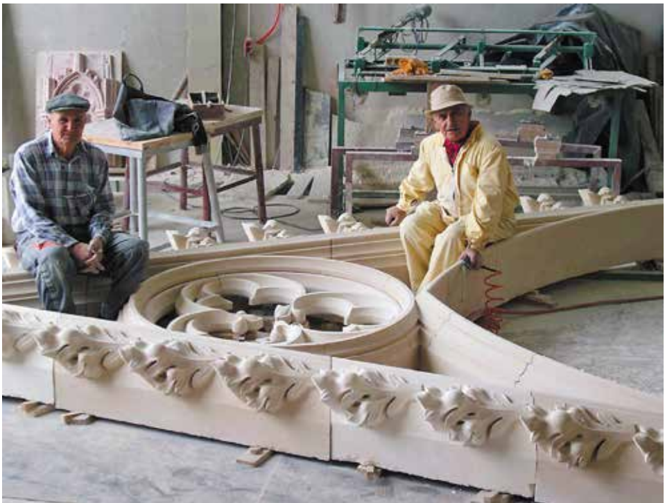
Prof. Vl. Herljević i klesar Jure Drpić prilikom radova na rekonstrukciji ukrasa zapadnog portala crkve sv. Marka u Zagrebu, 2008.
