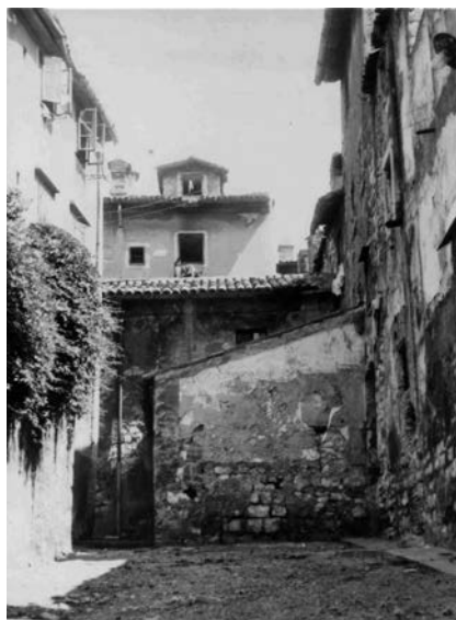
Slika 7. Pogled na južno pročelje crkve sv. Sebastijana i sakristiju te zapadno pročelje kuće br. 147
