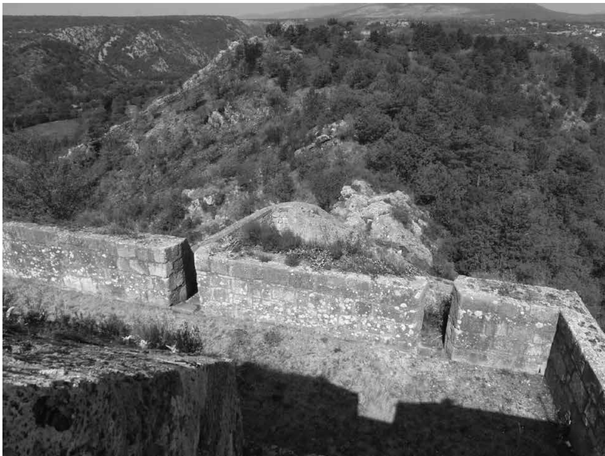
10. Baterija i sperone , sjeverni završetak tvrđave Battery and sperone, northern end of the fortress
