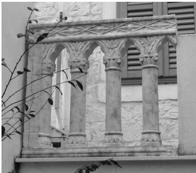
20. Kasnogotička ograda vanjskog stubišta sklopa Dragač Late Gothic parapet of the external staircase of the Dragač complex
