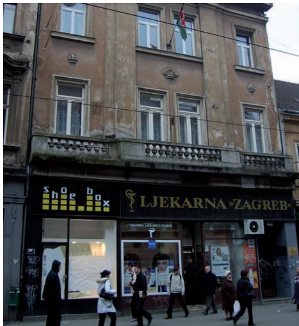
Slika 9. Današnje stanje zgrade, Ilica 43.
