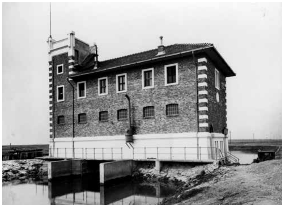
1924, San Giorgio di Nogaro (UD). Impianto idrovoro Consorzio di Bonifica Planais (Archivio Storico Fotografico Consorzio di Bonifica della Bassa Friulana)
