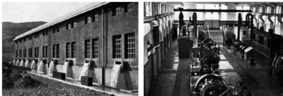
Agosto 1933, Pinguente (Buzet). Veduta dell'impianto di filtrazione e potabilizzazione, mediante generatori di Ozono, all'interno della centrale della rete del Quietò dell'Acquedotto Istriano (Archivio Storico Consorzio di Bonifica Bassa Friulana)
