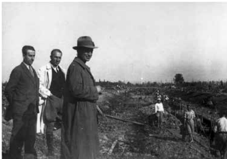
Fine Anni Venti del 900, San Canzian d'Isonzo (Go). In primo piano, con il soprabito bianco, l'ing. Lionello Ferrari mentre sovrintende ai lavori della realizzazione delle opere di bonifica di Isola Morosini
