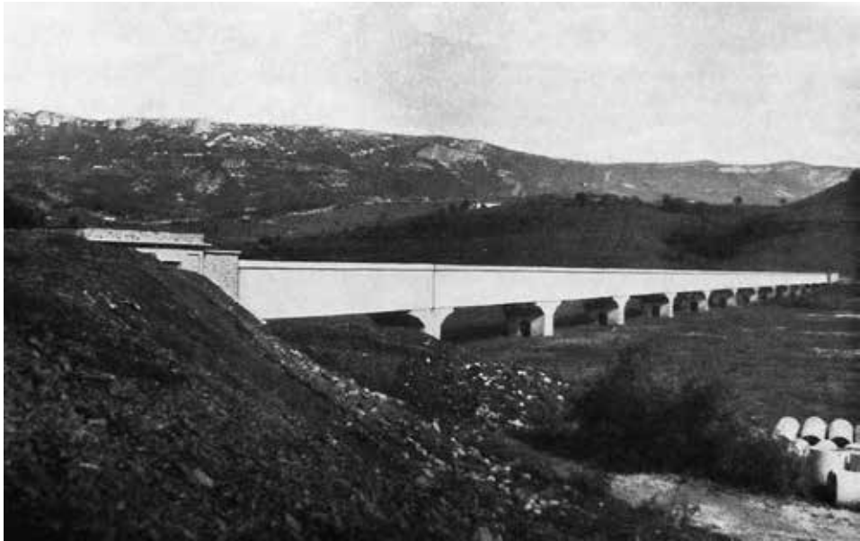
Settembre 1933, Acquedotto Istriano, rete del Quieto, Montona (Motovun). Veduta della condotta adduttrice principale a bassa pressione per l'attraversamento del torrente Malacuba (zona inondabile) (Archivio Storico Consorzio di Bonifica della Bassa Friulana)
