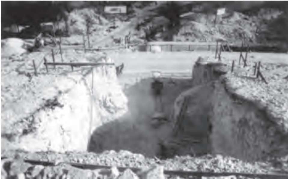
Costruzione della centrale di potabilizzazione e sollevamento alla fonte Gaia presso Arsia (1939)
